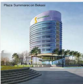
*) dalam tahap proses pembangunan
